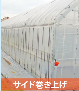
妻面固定張り
