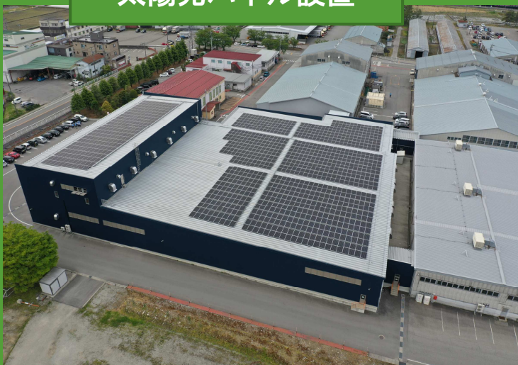
太陽光パネル設置
